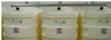
Slika 5b: Polnilni vod s krovno matico
