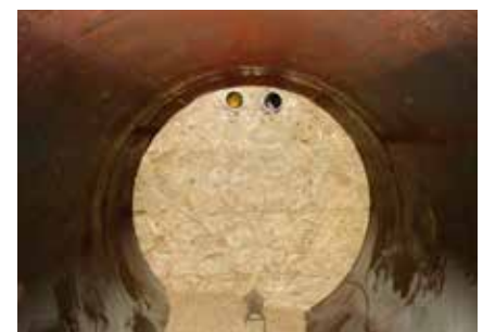
3 | Einbau einer Trennwand um den Tank zu einem Zweikammerntank umzurüsten.
