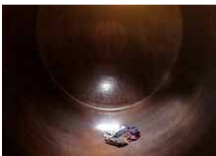
1 | Reinigung des Innentanks und entfernen evtl. Heizölablagerungen.
