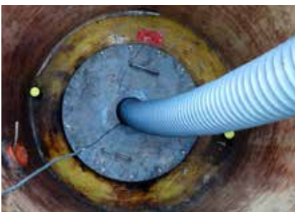
4 | Erhitzung des Tanks mit Heizgebläse zur Aushärtung des leitfähigen Beschichtungsmaterials.
