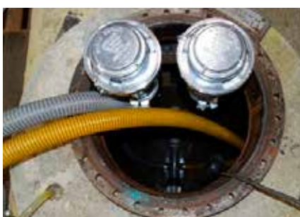
4 | Einbau der Entlüftung und Füllleitung mit Storz-Kupplungen.
