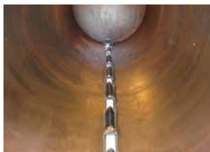
2 | Installation der Förderschnecke inkl. Saugübergabestation nach der Tankreinigung.
