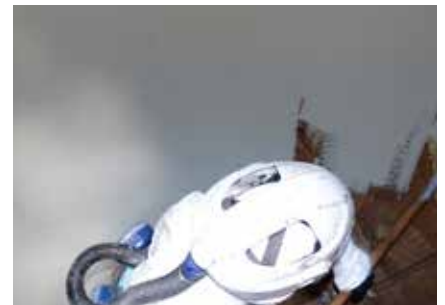
3 | Leitfähiges Beschichtungsmaterial wird auf die Tankinnenwand aufgetragen.
