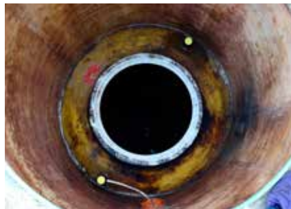
2 | Deckel für Heizöl und Leckwarneinrichtung demontiert, Anschlüsse für Leckwarneinrichtung verschlossen.
