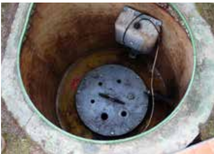
1 | Kugel vor der Umrüstung Heizöldeckel noch montiert, Behälter für Leckflüssigkeit noch vorhanden.
